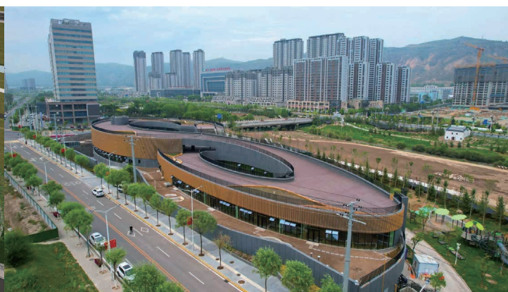
中国の西寧森林幼稚園。左が外観パース、右が竣工写真
